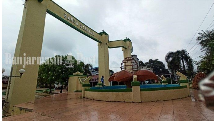
Gambar 4. 7. Pintu Gerbang Terminal Paringin, Kabupaten Balangan
